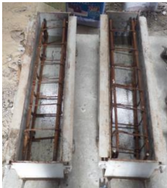
Figura 5 - Disposição das armaduras (Autores (2017))
