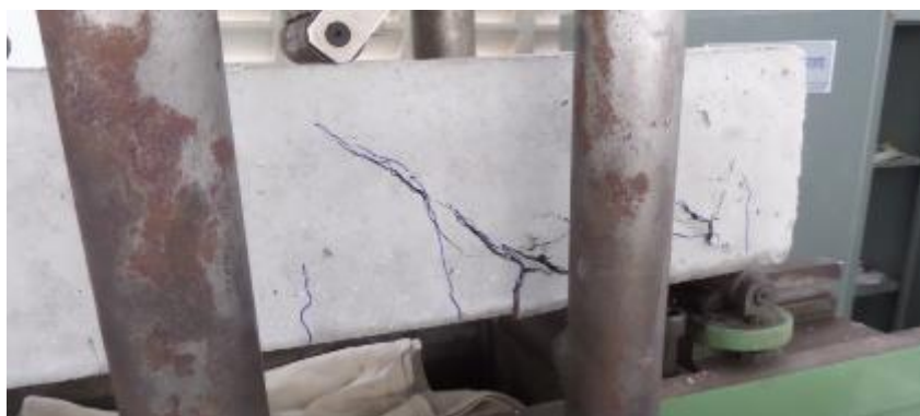
Figura 10 - Viga 1 após sua ruptura (Autores (2017))
